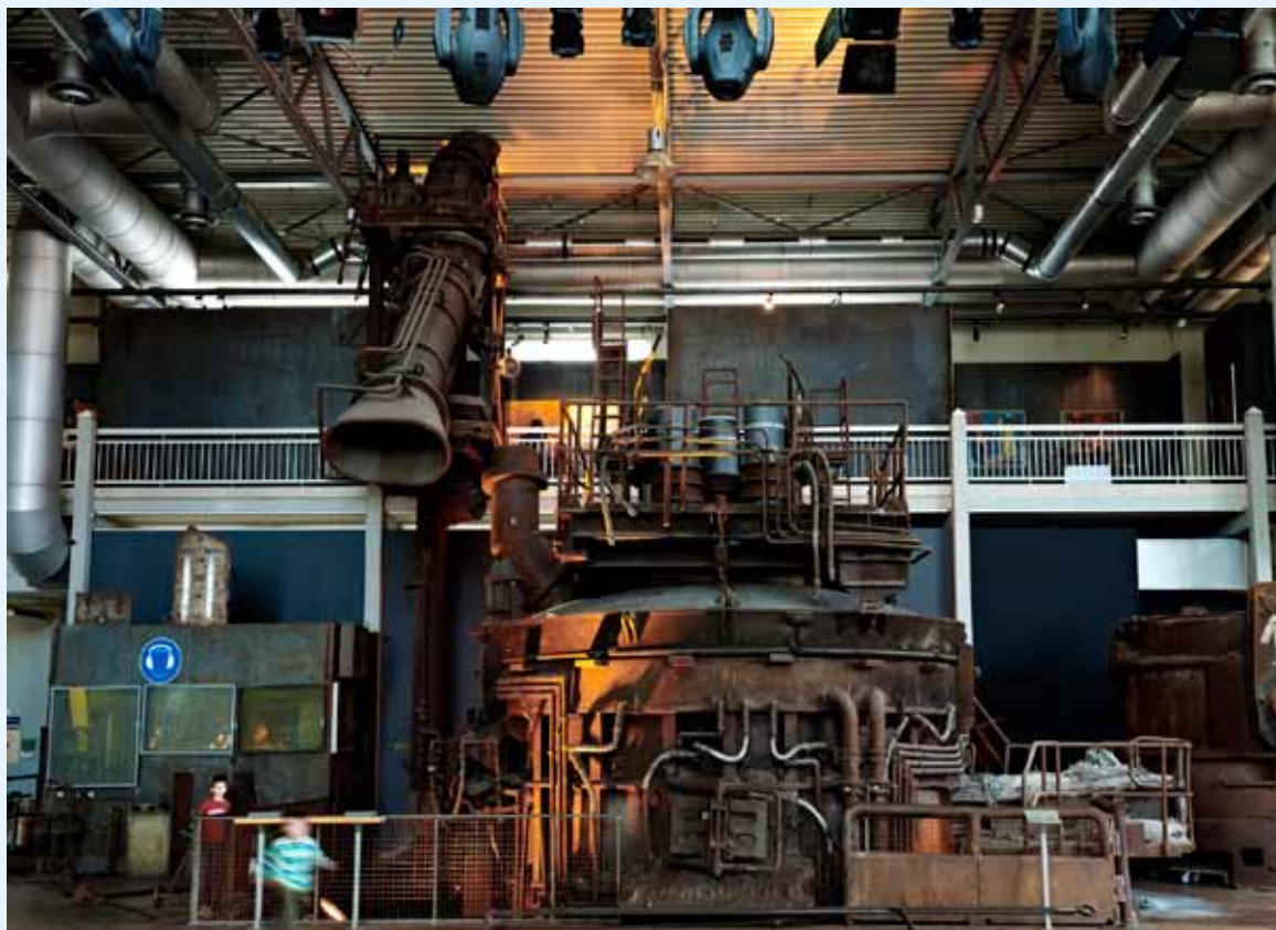
Stahlofen in der DASA. Foto: DASA / BEG Behler, Enker, Gasenzer
